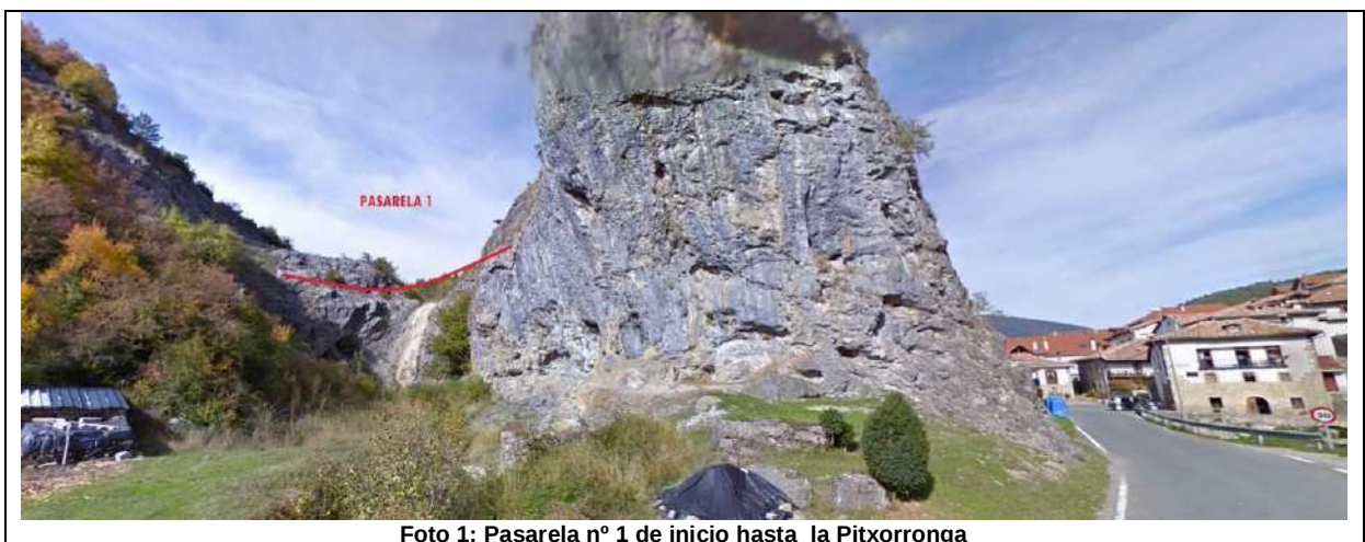
Foto 1: Pasarela nº 1 de inicio hasta la Pitxorronga
