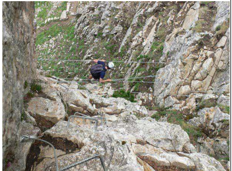
Foto 1: Pasarela con dos pasamanos y grapas en una imagen captada en internet
