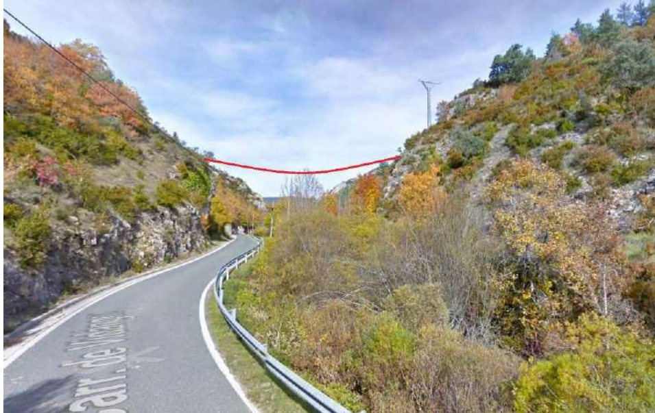
Foto 1: Pasarela nº 3 en Peña Ancha
