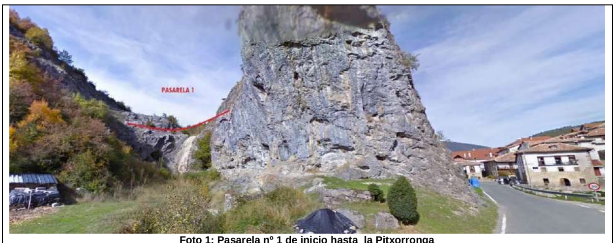
Foto 1: Pasarela nº 1 de inicio hasta la Pitxorronga
